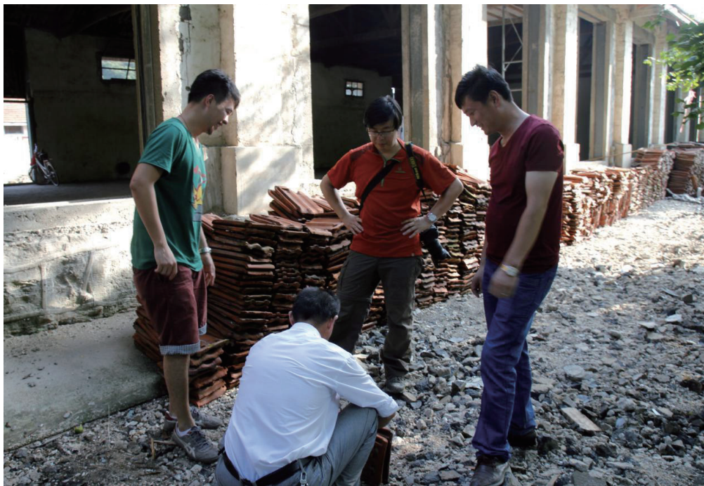
设计团队在西河村现场指导施工
